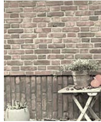
bakstenen pint van 30mm terugliggend staand metselwerk
