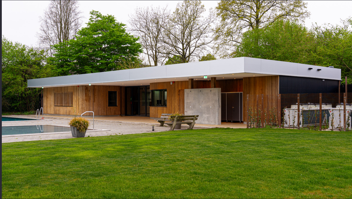
Zwembadgebouw vanaf het zonnenveld
