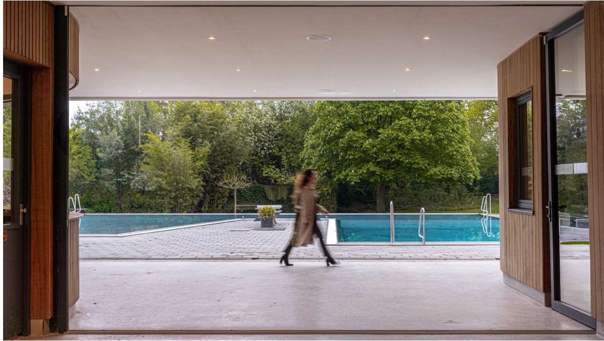
Harmonicapui valt weg in wand
