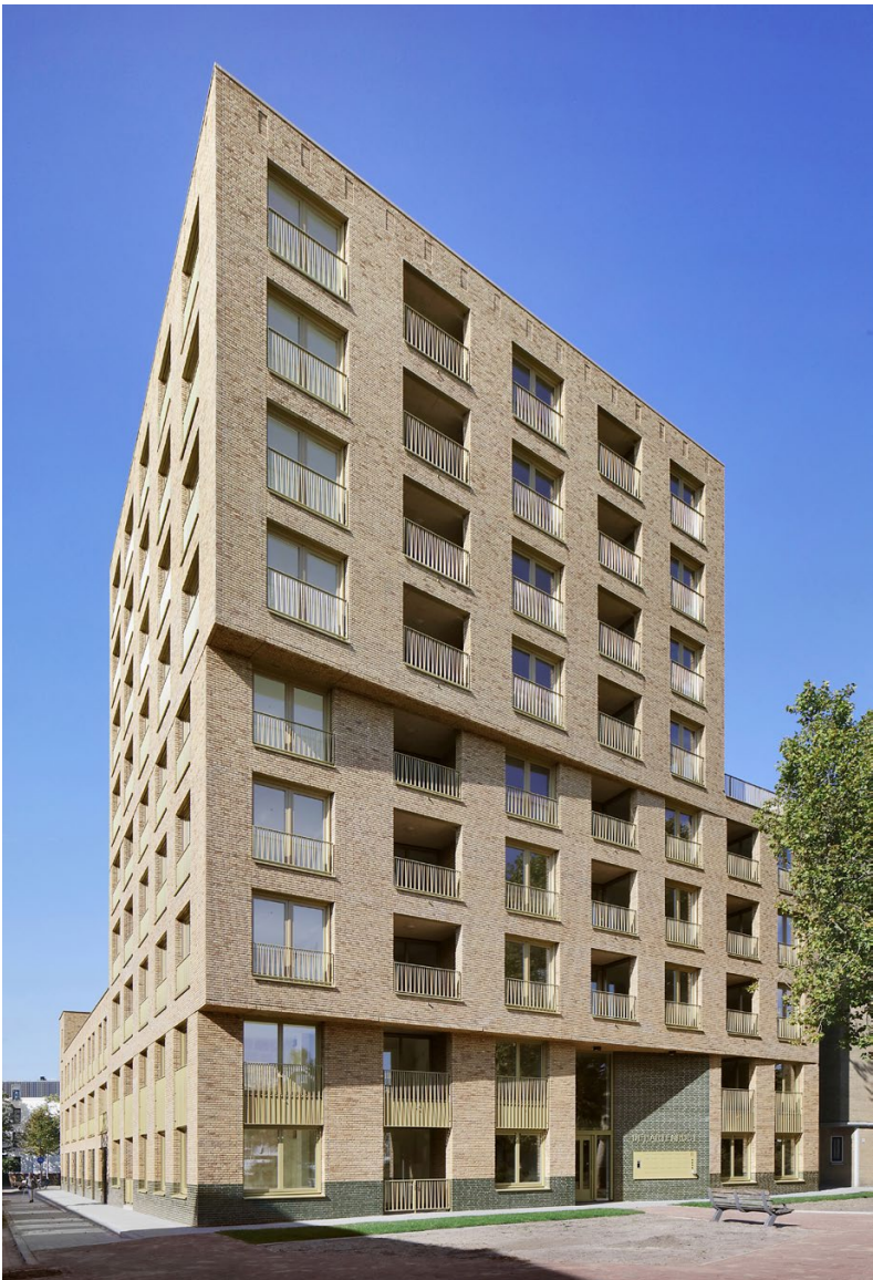
Franse balkons met circulaire kozijnen en geïntegreerde zonwering
