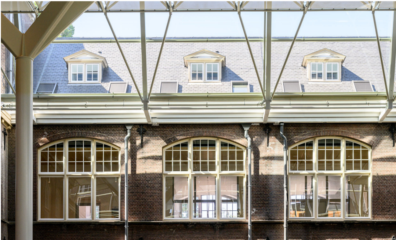
Aansluiting nieuwe overkapping op bestaand gebouw
