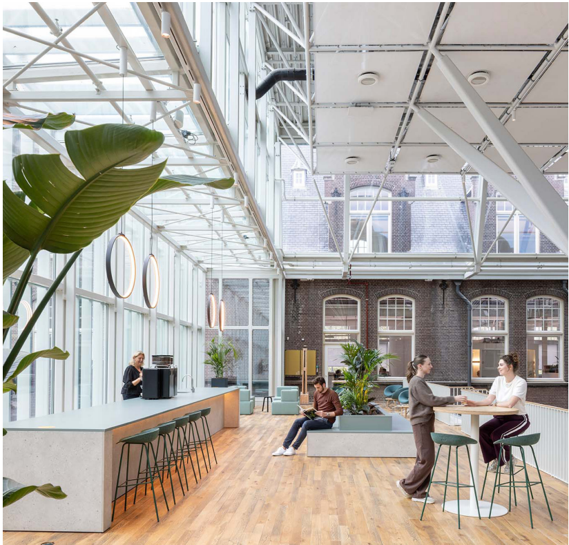
Aansluiting nieuwe serre op de zuidgevel
