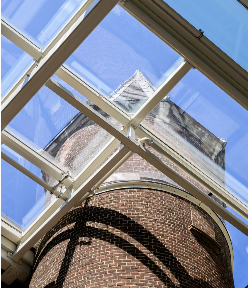
Aansluiting nieuwe overkapping op bestaand torentje
