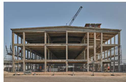
Het betoncascos van gebouw 72 tijdens de bouw
