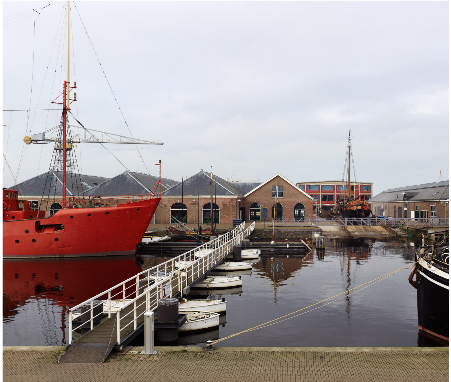
Gebouw 66 met gebouw 72 op de achtergrond
