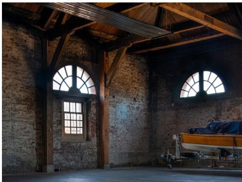
Gebouw 66, voor aanvang van de renovatie
