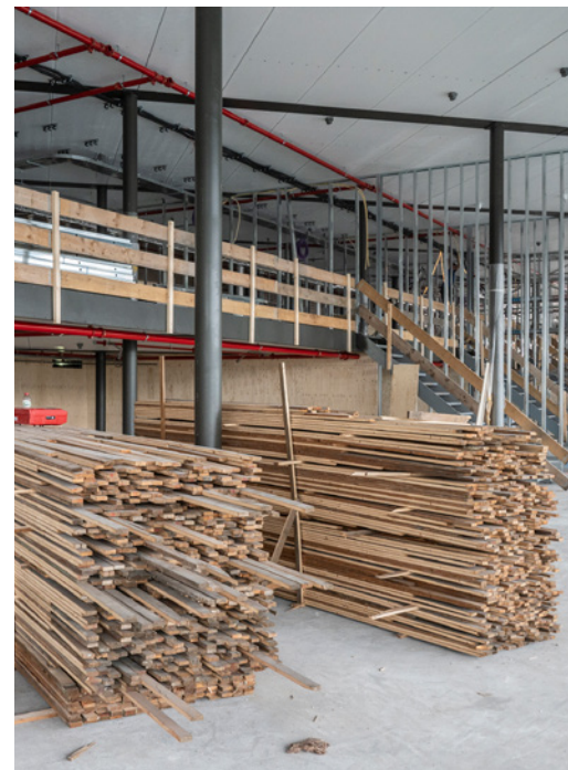
Veel van het geogoste hout is hergebruikt als akoestische wandbekleding. Daaronder bevindt zich nog een laag met isolatiemateriaal samengesteld uit oude spijkerbroeken. De verschillende lampen in het gebouw zijn geogost uit andere fabrieksgebouwen.
