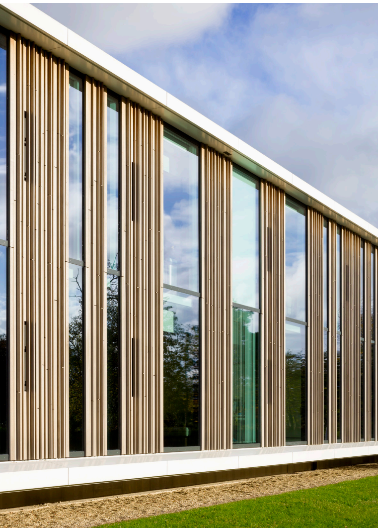
Verduurzaamd houten gevel
