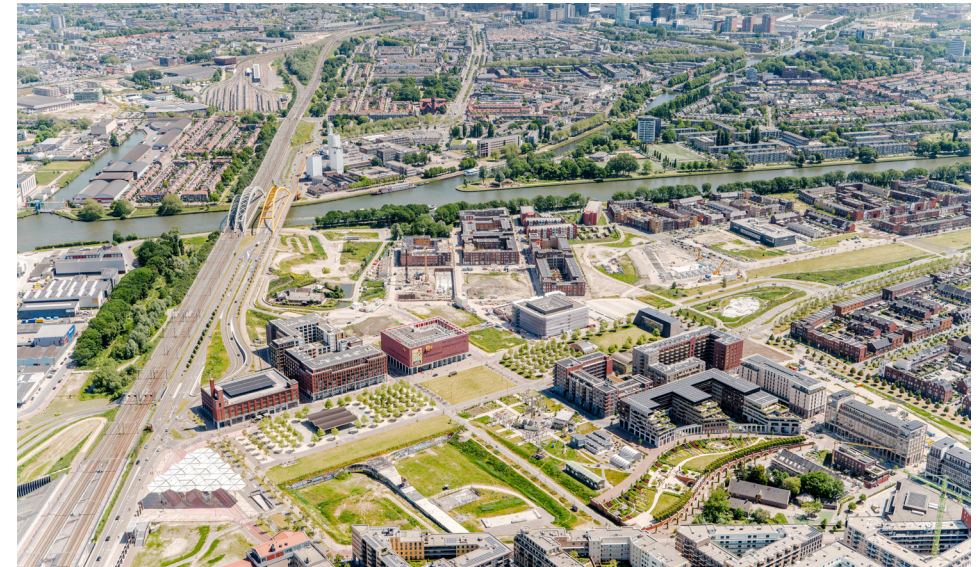
Academie Tien (nog in aanbouw) aan het verhoogde Berlijnplein waar de A2 tunnel onder ligt. (foto: Your Captain Luchtfotografie)
