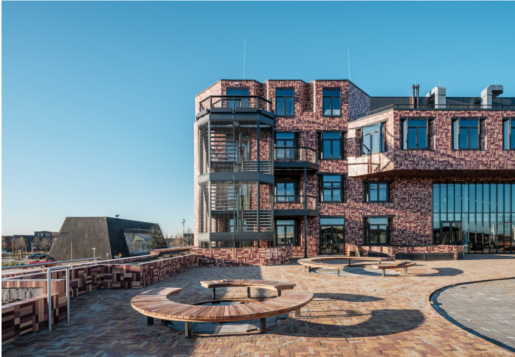
De sporthal is voor 2/3 ondergronds geplaatst en biedt daardoor ruimte voor een riant verhoogd openbaar plein.
