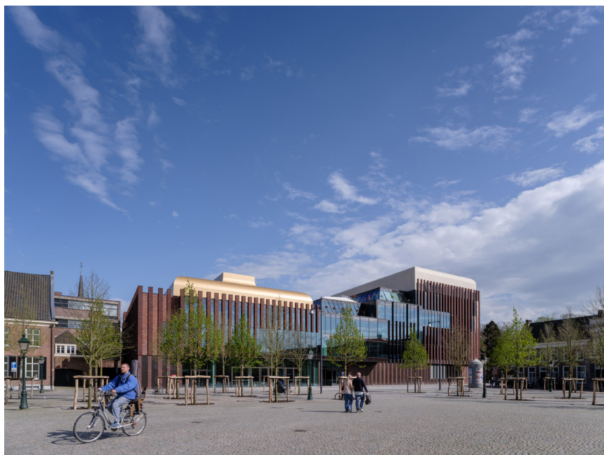
Vakmanschap in het metselwerk
