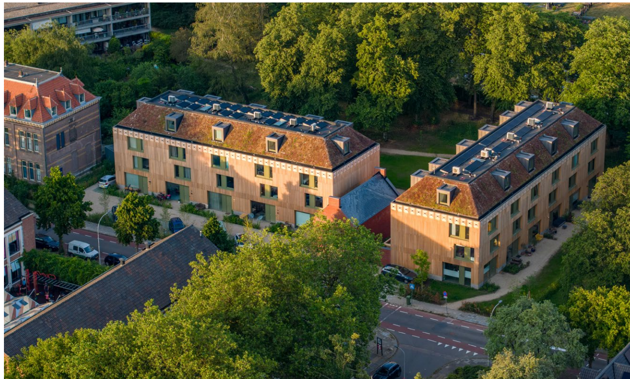
De gevels van Hortus Ludi refereren in compositie, detaillering en kleurgebruik naar de monumentale gebouwen binnen het kloosterensemble.
