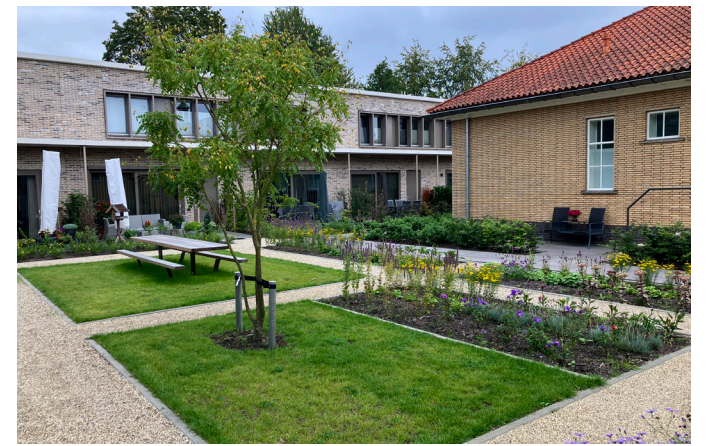
Een van de nieuwe hoven die de oud- en nieuwbouw verbindt
