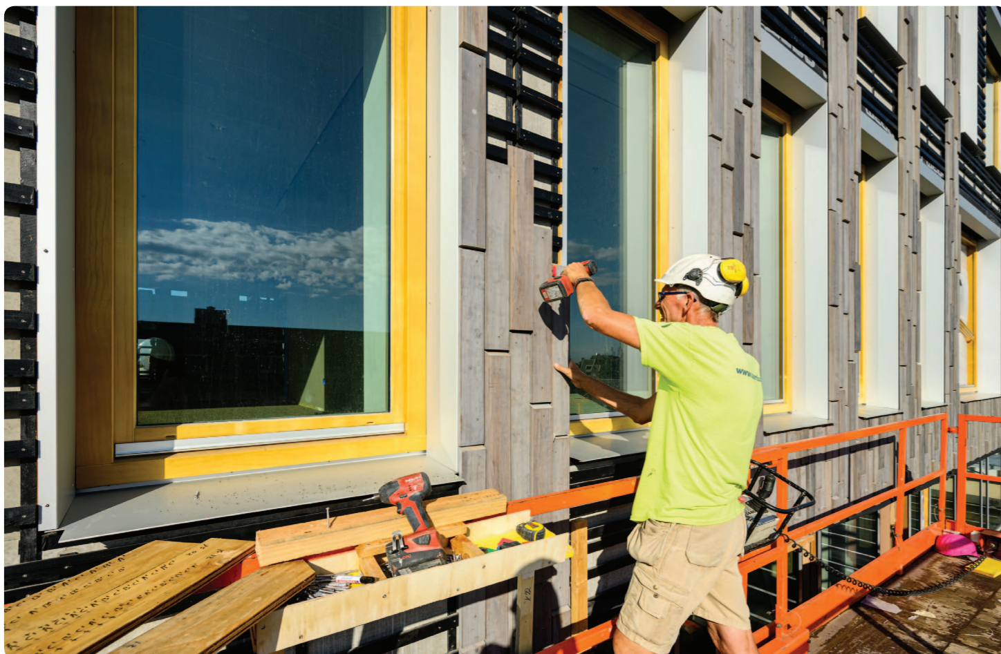
montage 90.000 geschroefde latten
