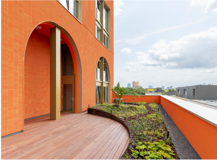
↑ OM HET WAAGGEBOUW NATUURINCLUSIEF TE LATEN ZIJN IS EEN GROTE GROENE DAKTUIN IN HET GEBOUW OPGENOMEN.
