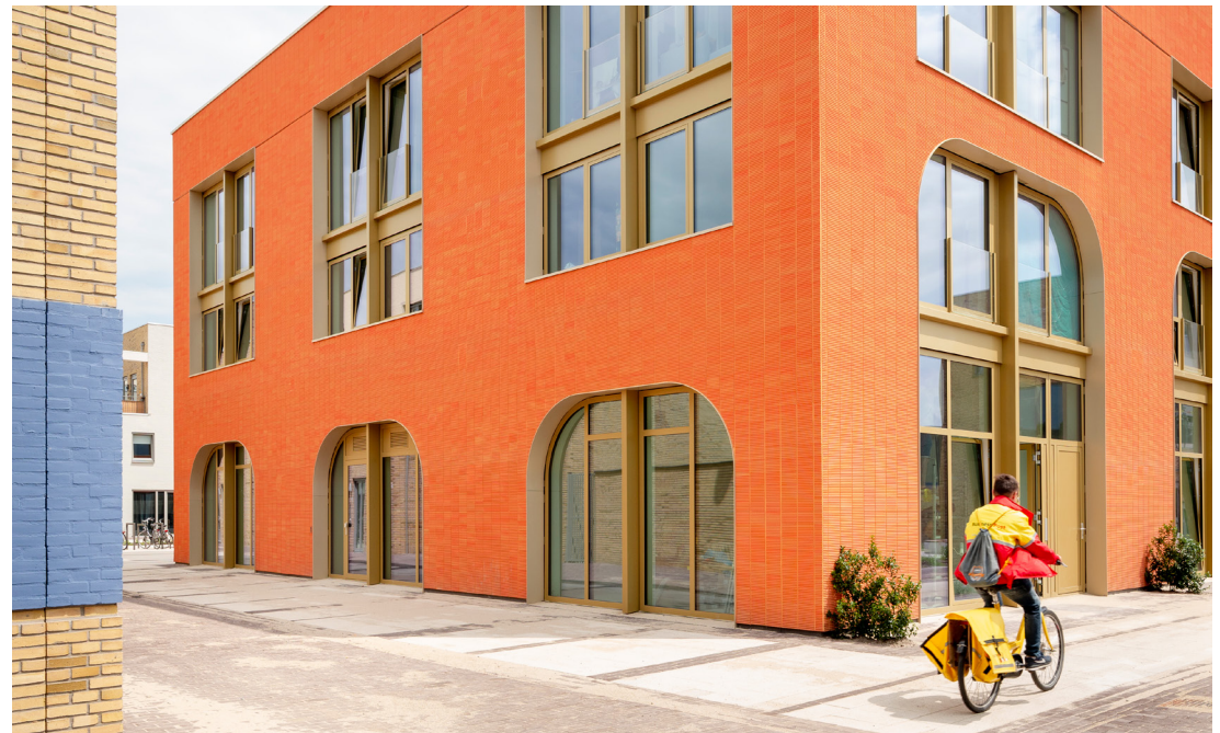
↑ DE GEVEL IS BEKLEED MET ECOSHAPES, EEN DUURZAAM ALTERNATIEF VOOR TRADITIONELE STEENACHTIGE GEVELS OF STUC.
