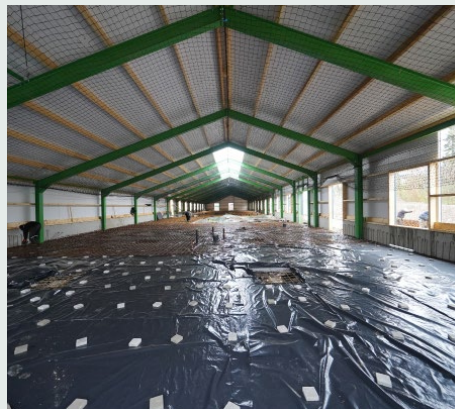
BINNENZIJDIGE BASIS LOODS
