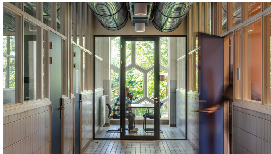
Nu zijn de verlaagde plafonds verwijderd en installaties toegevoegd in de gangen. Hierdoor is de oorspronkelijke architectuur versterkt en kan er meer daglicht naar binnen vallen. Daarnaast zijn aan het einde van de gangen nog spreekruimtes toegevoegd.
