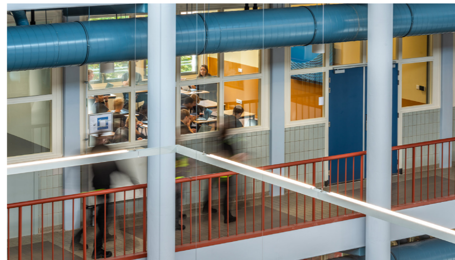
Voor het gehele gebouw is een kleurconcept doorgevoerd op basis van kleurhistorisch onderzoek. Ook nieuwe elementen zoals de kanalen sluiten zo aan bij de bestaande architectuur.
