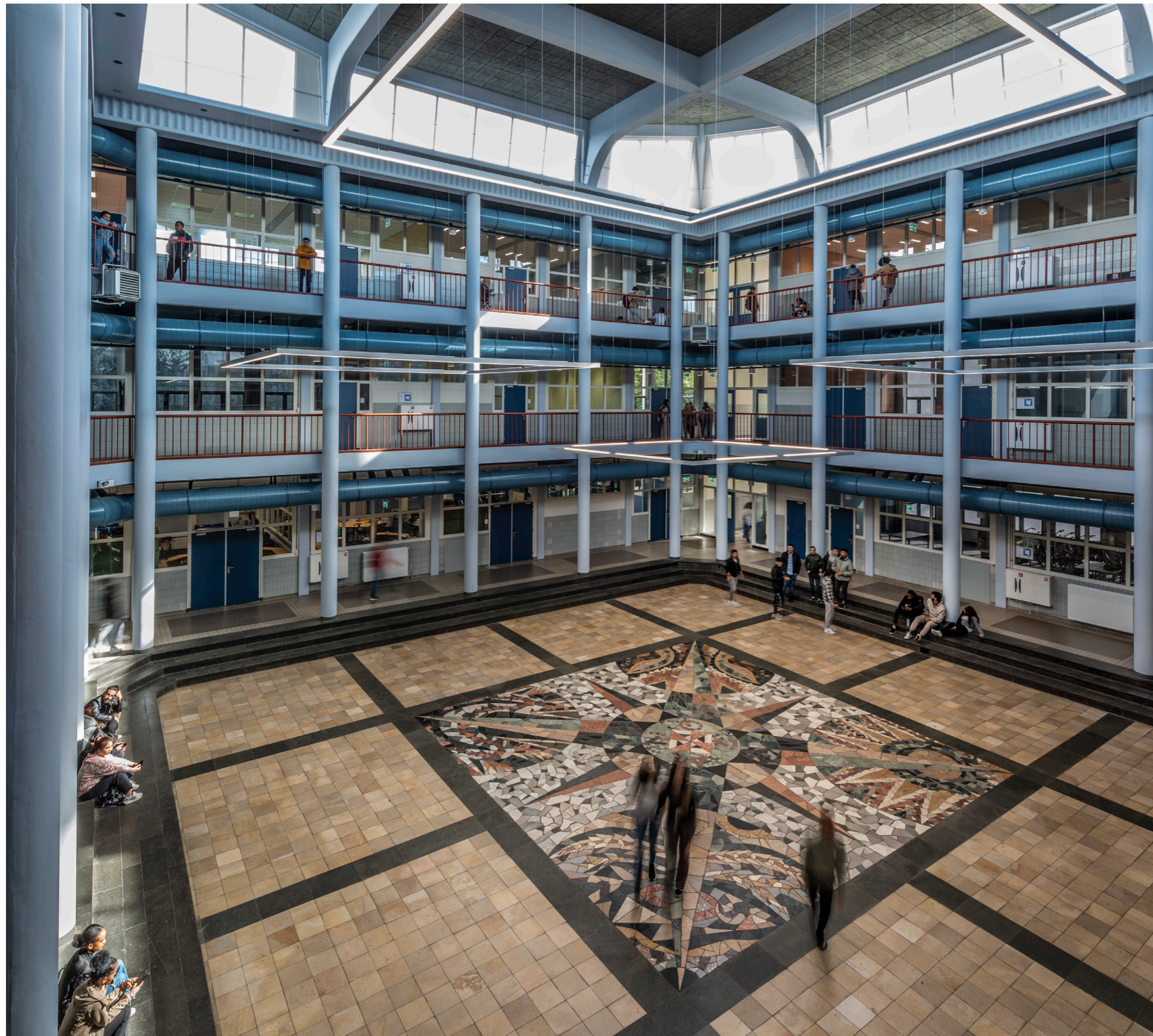
Kloppend hart van De Meppel is nog steeds het grote atrium, dat als belangrijke verbinder tussen alle opleidingen fungeert. Hier is de oorspronkelijke mozaïekvloer van kunstenaar Marius de Leeuw weer in ere hersteld. Daarnaast is op basis van kleurhistorisch onderzoek door Willianne van der Sar een passend kleurconcept doorgevoerd.
