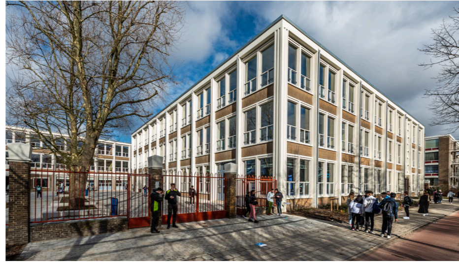
Dankzij de renovatie blijft deze bijzondere school behouden voor Den Haag Zuidwest. Ook in de gevel zijn de kleuren gebaseerd op uitgebreid kleurhistorisch onderzoek door Willianne van der Sar.
