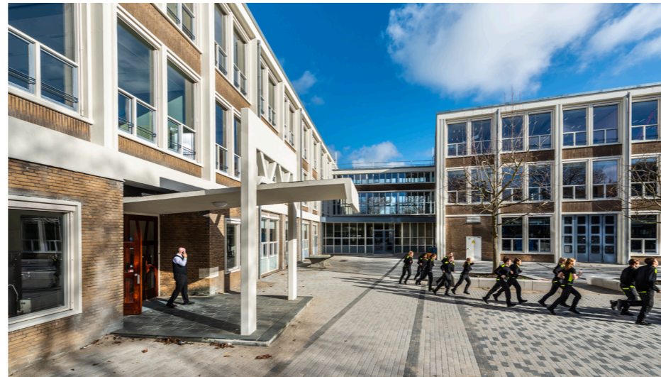
In de gevel zijn de later toegevoegde ventilatioosters verwijderd en is nieuwe zonwering toegepast. Dankzij een zorgvuldig in stijl ontworpen nieuwe doorvalbeveiliging zijn de ramen van de lokalen weer te openen.
