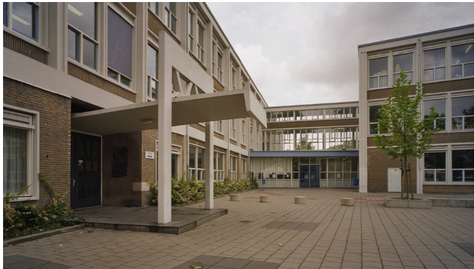
Archiefbeeld uit 2002: na de renovatie in de jaren negentig was de oorspronkelijke kozijnindeling opgesplitst door een tussenkalf ten behoeve van zonwering en grote ventilatioosters.
