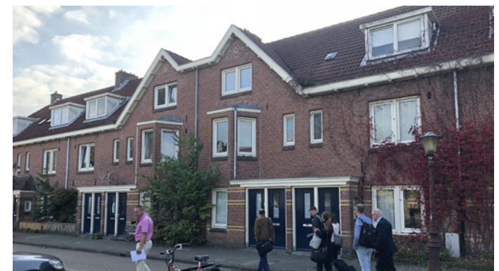
Situatie in 2019 Blok 17 Meidoornplein
