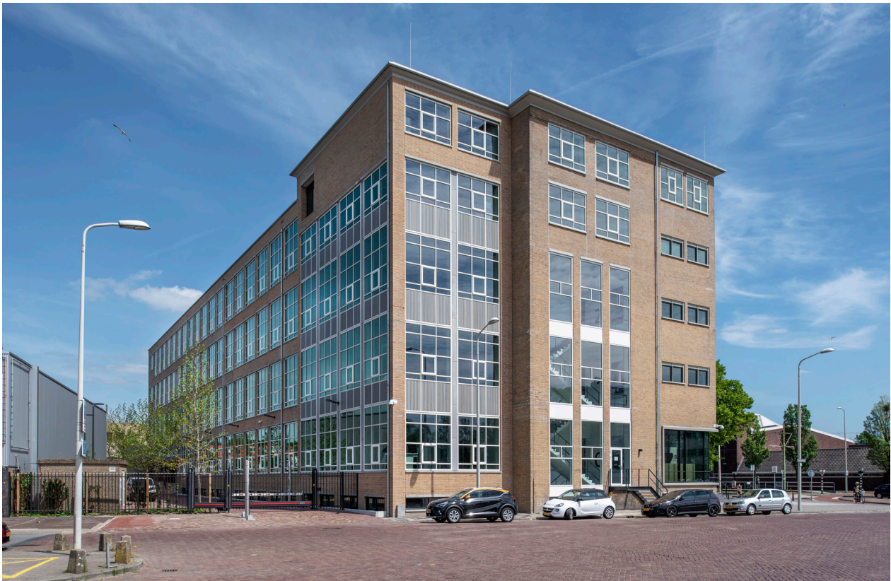
Vernieuwde kop- en achtergevel
