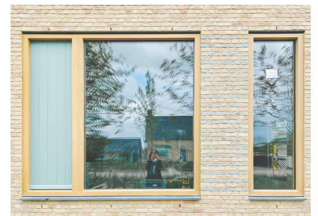
detail gevel met gekleurd luik en geglazuurde bakstenen kleurloos geschilderd massief eikenhouten kozijnen
