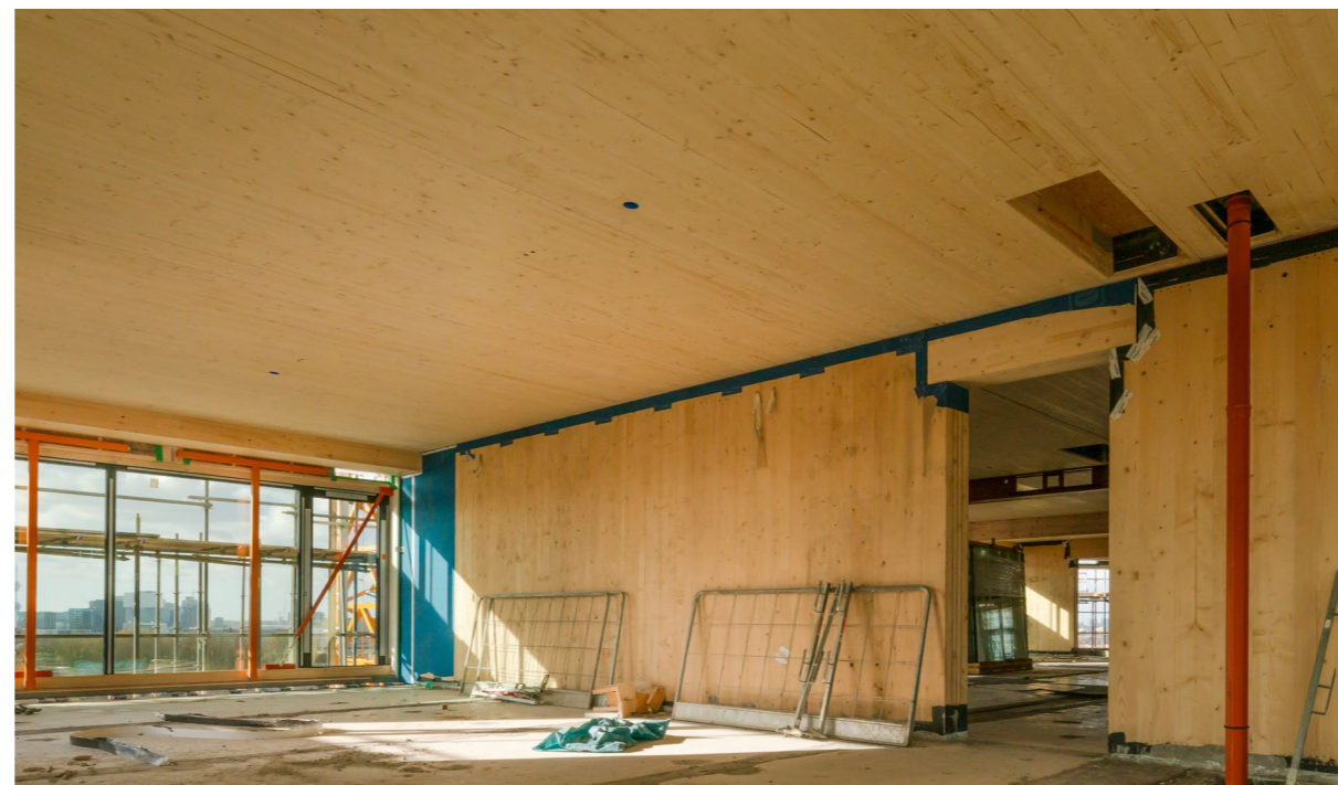
Alle vloeren en wanden zijn van houten CLT-panelen
