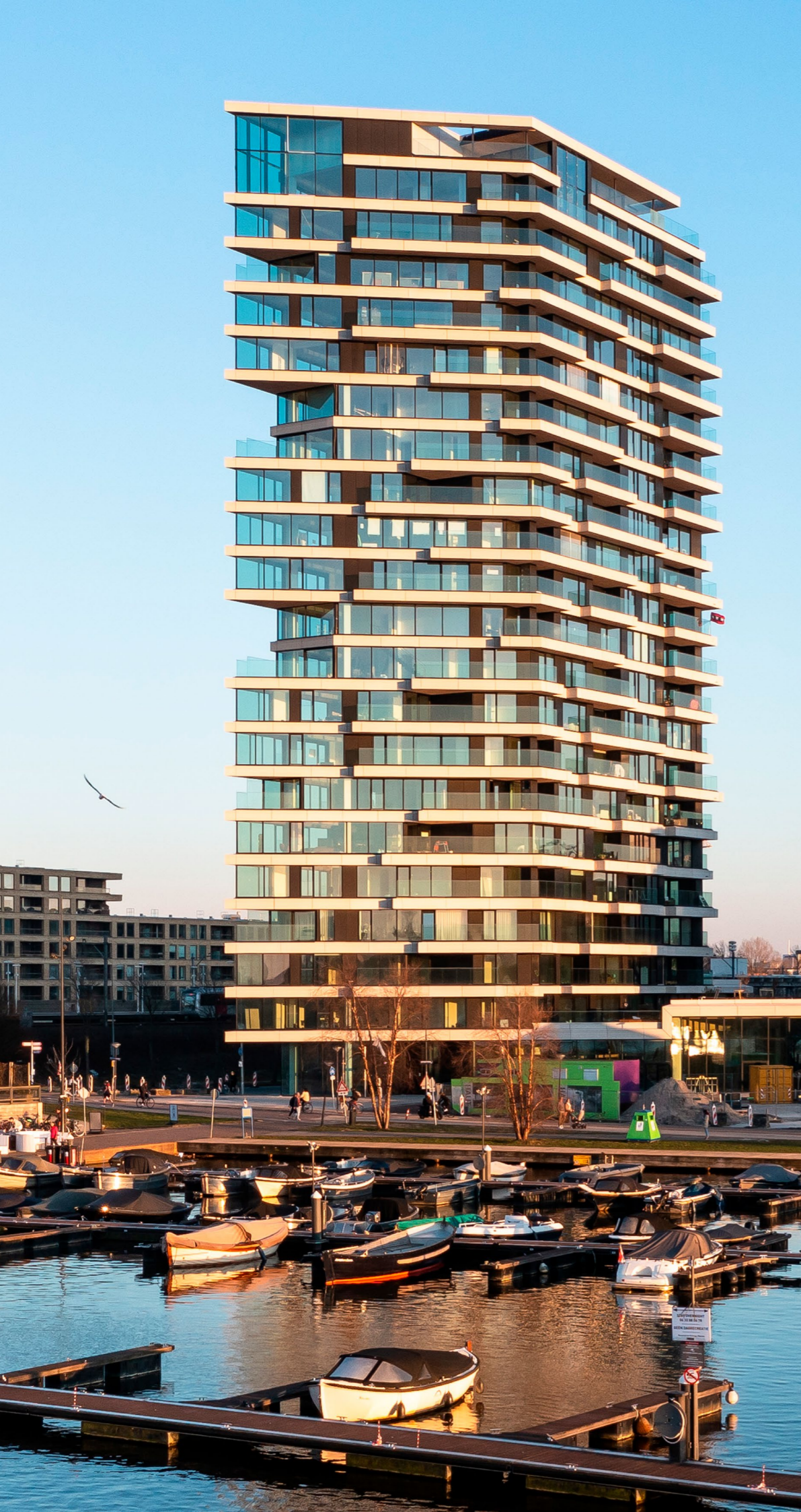
Hybride houtconstructie: fundering, liftkern en deel van de plint van beton, vloeren en wanden van hout.
