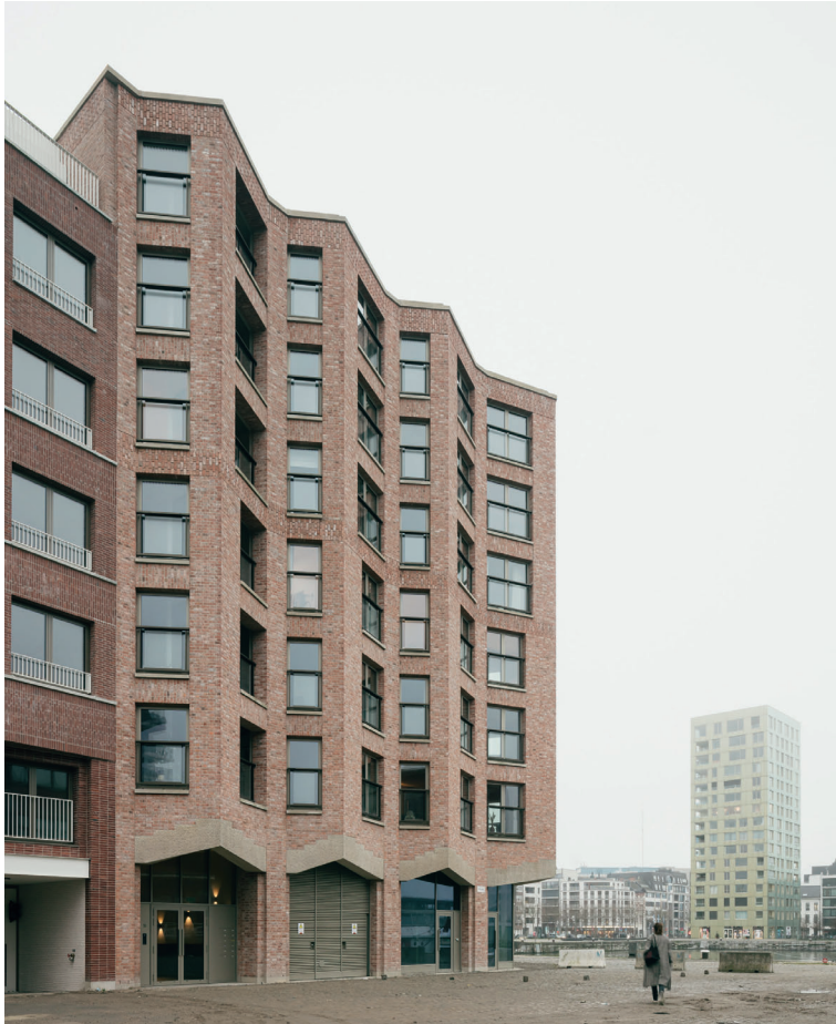
← Sergison Bates ontwierp het zichtbaarste deel, met gegeerde appartementen langs het water.
