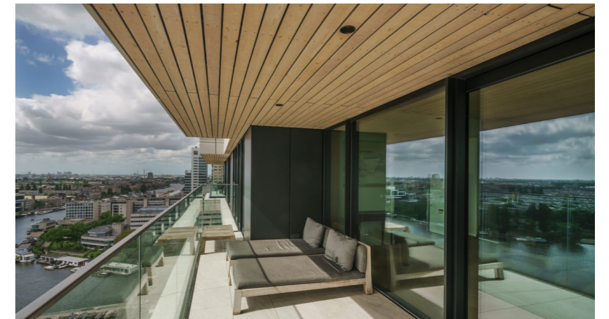
Uitzicht vanaf balkon: transparantie, mogelijk gemaakt doordat er geen constructieve elementen in de gevel zitten
