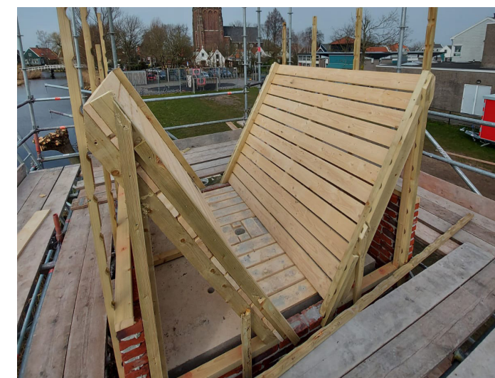
dakconstructie voor vleermuizen bereikbaar via spouw en gaten in de betonnen dakplaat
