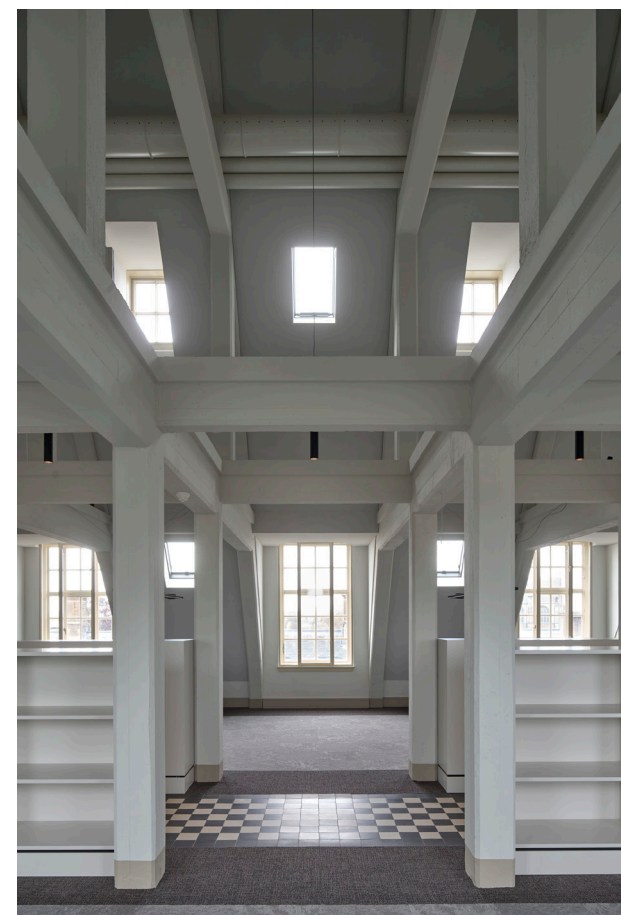
Zolders met het beton casco in zicht
