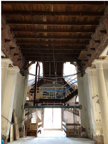
Oude + nieuwe situatie monumentale trap: - Toegevoegde wand en verlaagd plafond verwijderd - Oversteek kanalen van Oost naar West - Herstel kroonlijst / in maat aangepast - Teruggehaalde 'seizoennekes'
