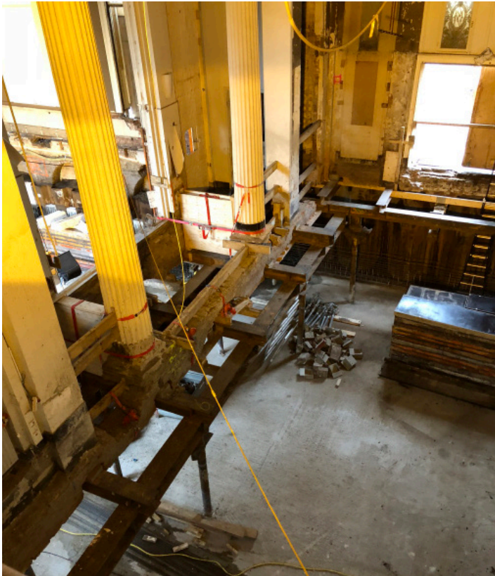
Stalen tafel die de hele rotonde draagt t.b.v. vernieuwing fundering onder de bestaande bouwmuur
