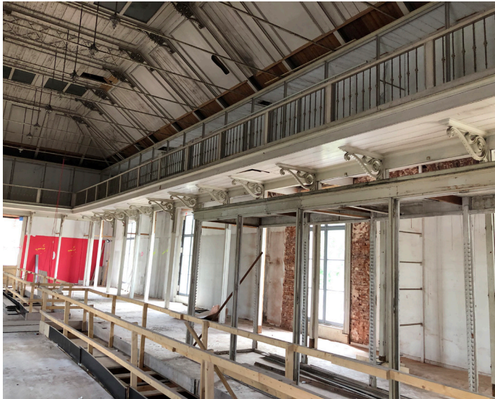
Alle vitrinekasten hebben het gebouw verlaten, het fragiele glas is verdubbeld. Subtiële versterkingen toegevoegd.
