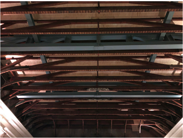
Versterking met stalen liggers van onderuit aangebracht om vloer boven te sparen
