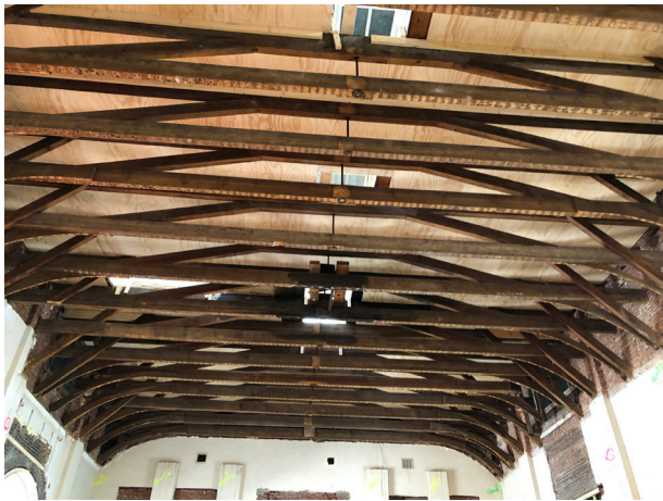
Plafond van van Maurik, nooit eerder zichtbaar. Dubbele balklaag t.b.v. grote overspanning van de zalen.
