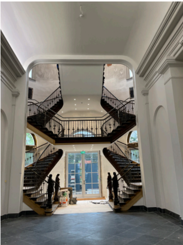
Oude + nieuwe situatie monumentale trap: - Toegevoegde wand en verlaagd plafond verwijderd - Oversteek kanalen van Oost naar West - Herstel kroonlijst / in maat aangepast - Teruggehaalde 'seizoennekes'
