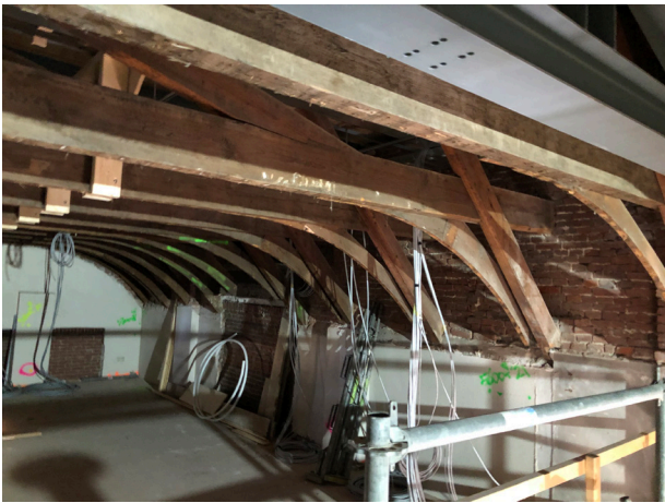
Versterking met stalen liggers van onderuit aangebracht om vloer boven te sparen
