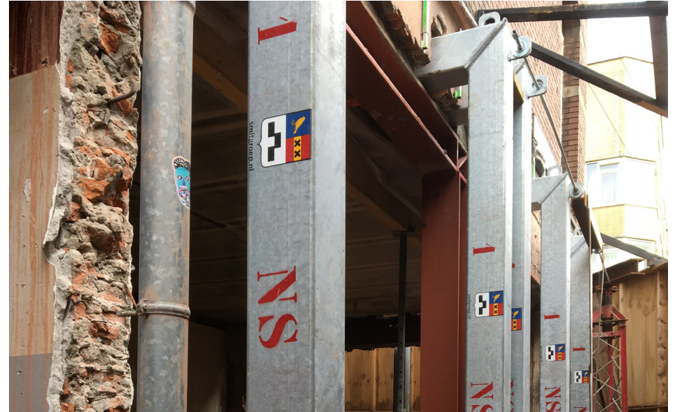
slopen en ruwbouw
