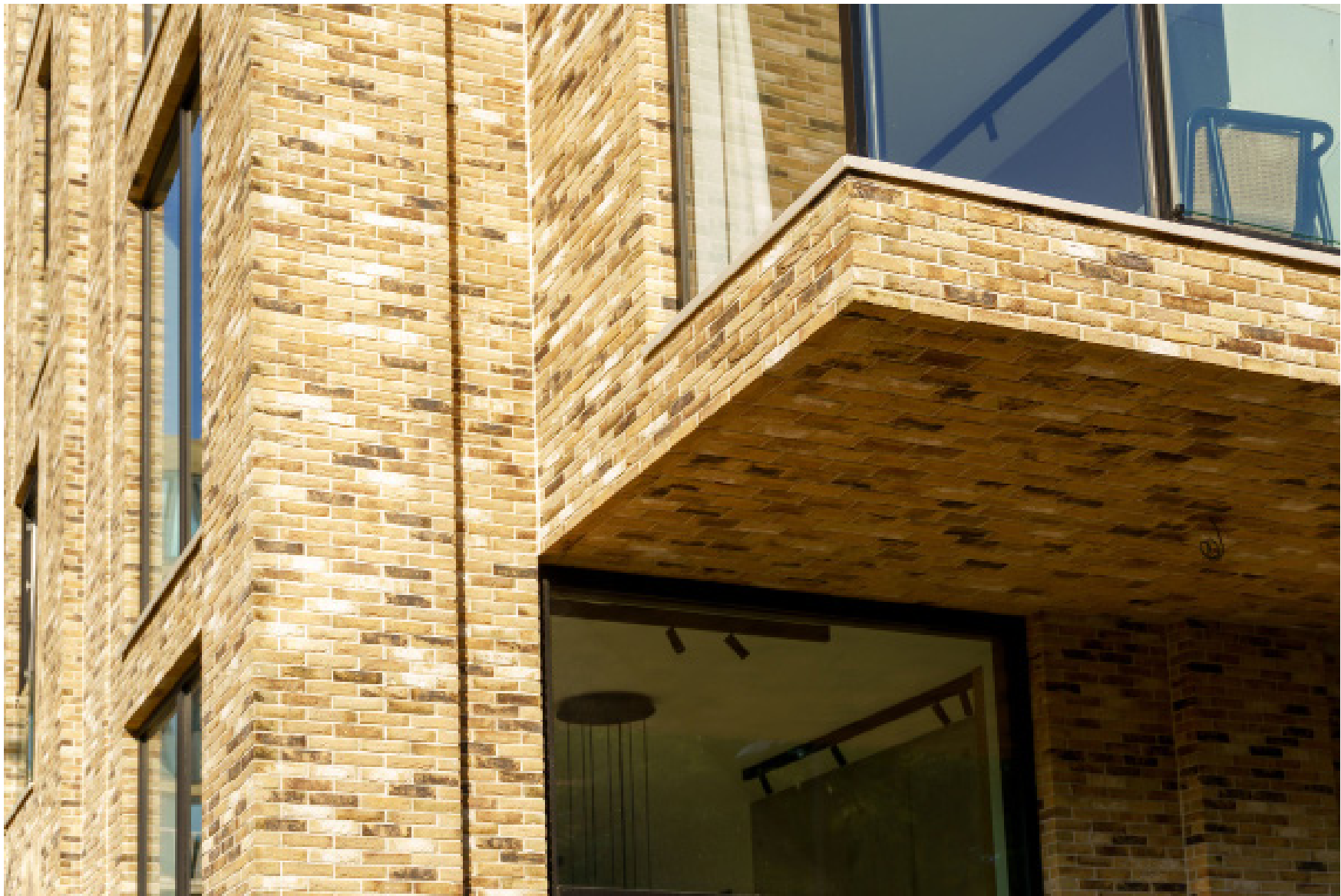
detaillering erker ingeklemd tussen de penantstructuur
