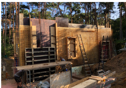
Bekistingspanelen in werf
