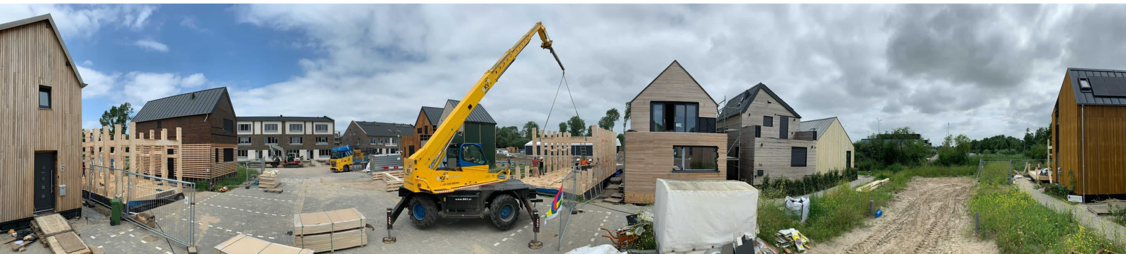
WikiHouse de Stripmaker fase 1 en 2 in aanbouw, foto's: WikiHouseNL = open source
