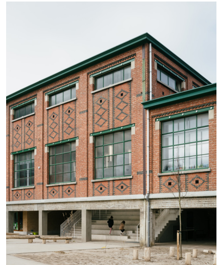
Nieuwe toegangstrap onder het bestaande gebouw
