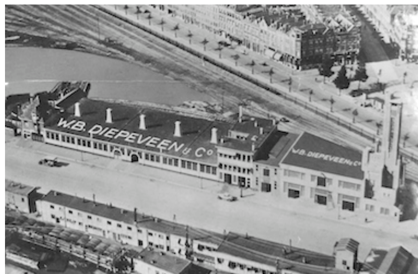
historische foto Diepeveen complex
