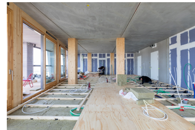
Appartement tijdens inbouw individuele indeling met gedeeltelijk uitgevoerde topvloer
