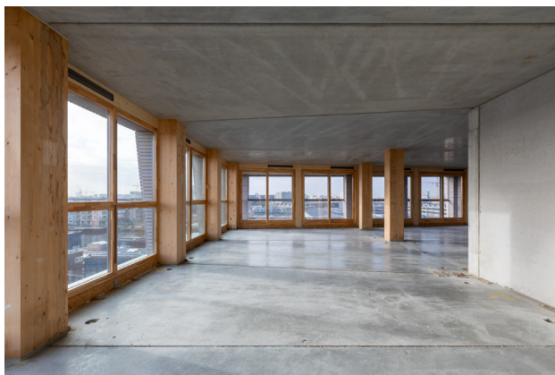
Casco appartement bij oplevering, zonder door kopers te realiseren topvloer
