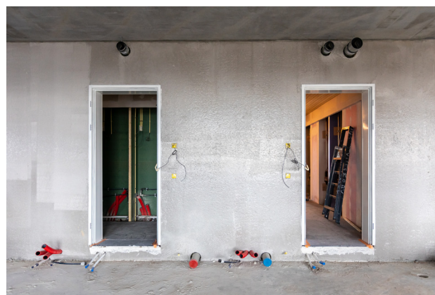
De kopers kunnen hun installatie aansluiten op de afgedopte leidingen onder de voordeuren.
