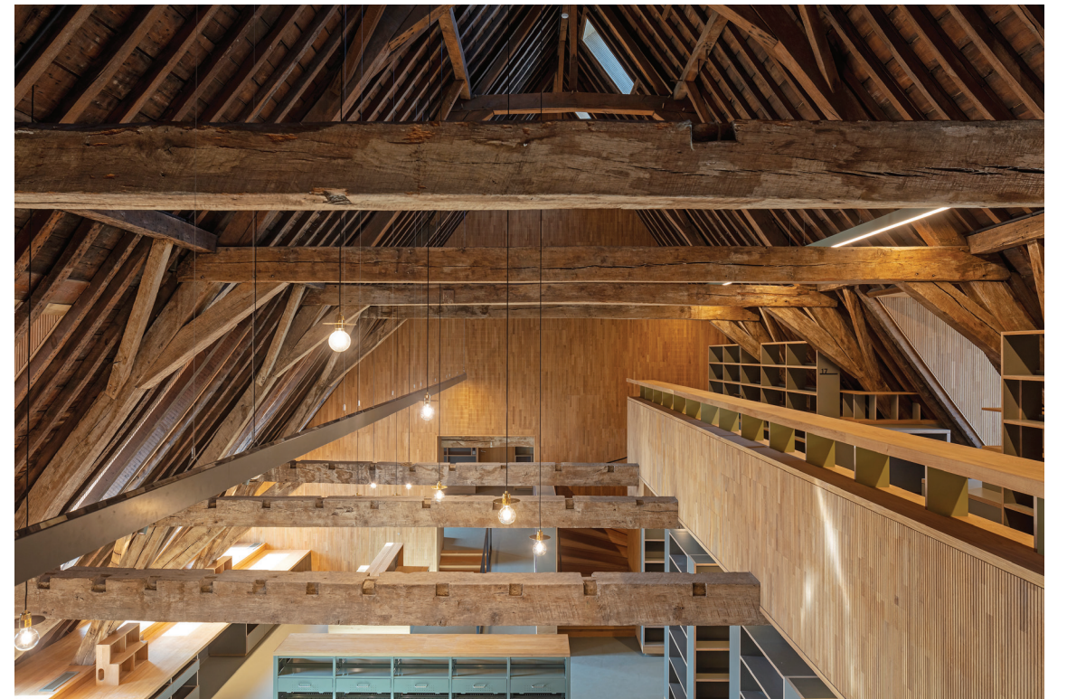
studielandschap gezien vanaf de mezzanine, inrichting informele studie- en werkplekken
