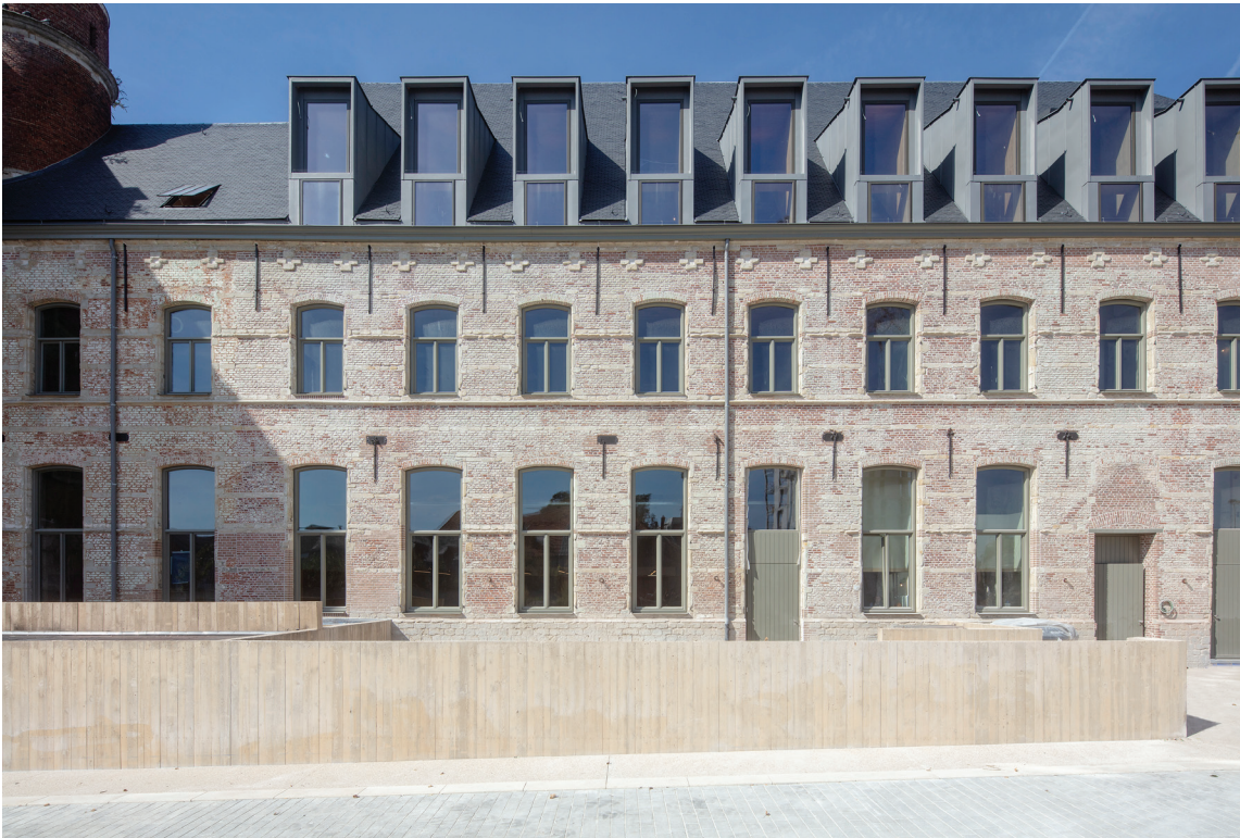
synergie van de nieuwe architectuur op het bestaande architectonische beeld
