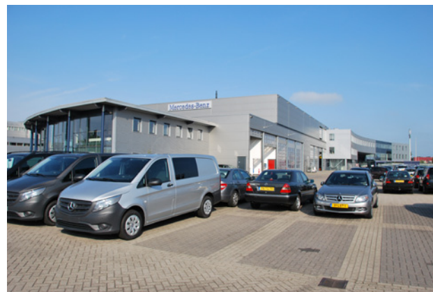
Bestaande gebouw gezien vanaf de entreezijde aan de Donau
