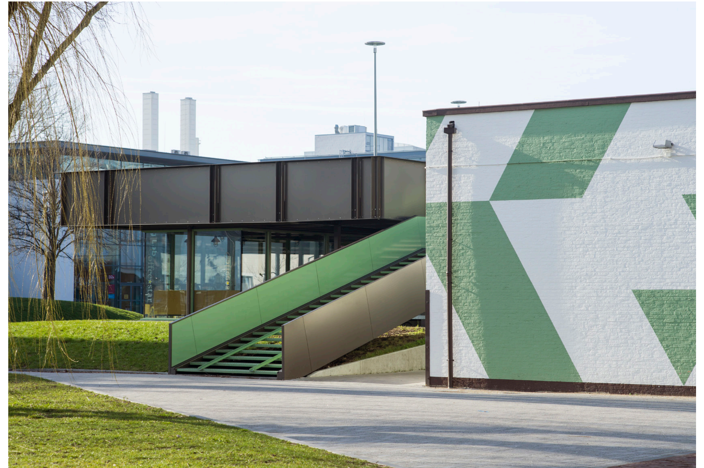
Het transformatorhuis dat zich op de hoek van locatie bevindt, is als baken aan het ontwerp toegevoegd. De verschillende entrees en trappen naar het maaiveld maken het gebouw aan alle kanten toegankelijk en zorgen voor een alzijdige uitstraling.
