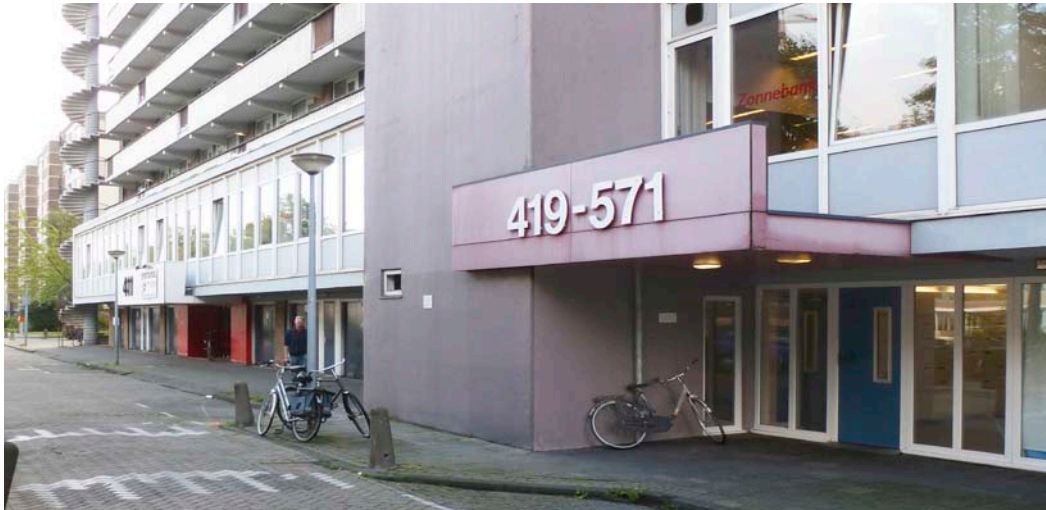
De oorspronkelijke staat van de galerijflat aan De Boelelaan in 2015. Original condition of the social housing block in 2015.
