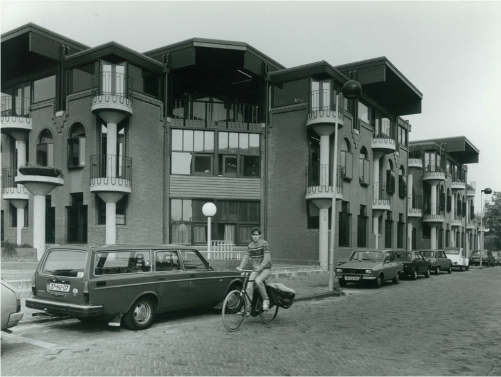
Cluster Zuid in Leiden voor renovatie
