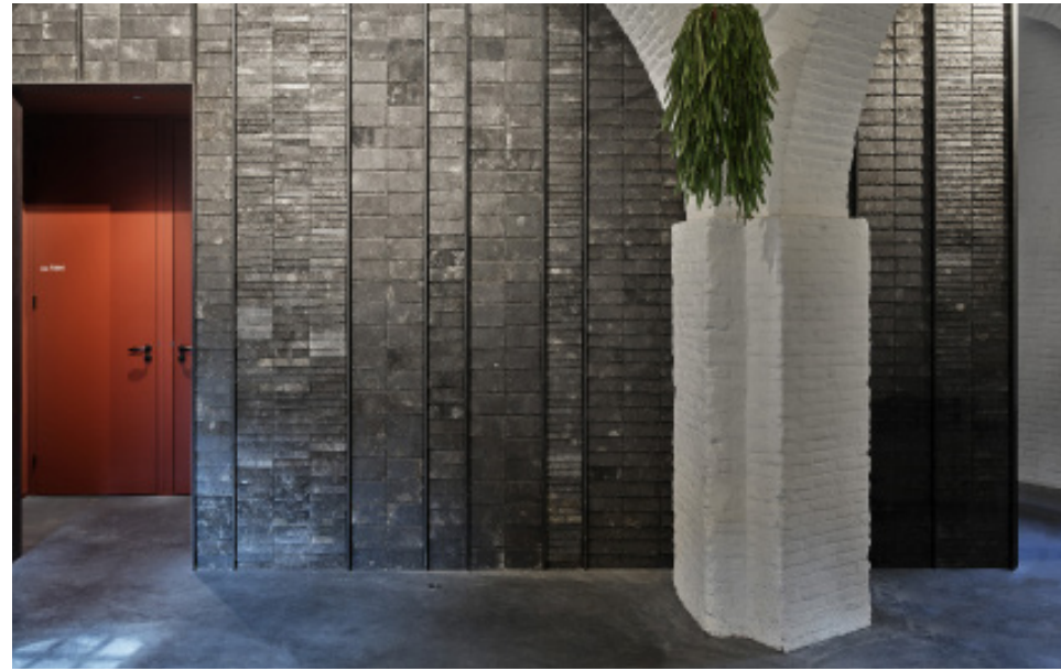
Oude dakleien als wandbekleding
