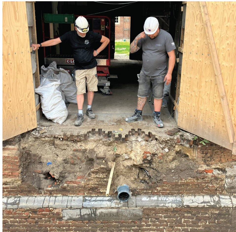
In het werk an de brug
