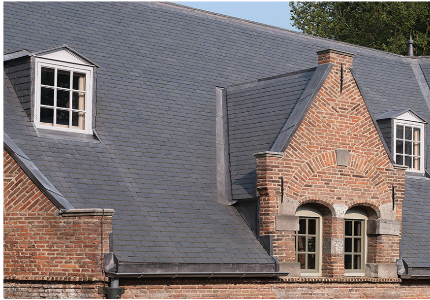
Nieuwe dakleien op het dak
