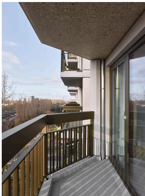
Balkon westgevel met gepolijst betonnen plafond
