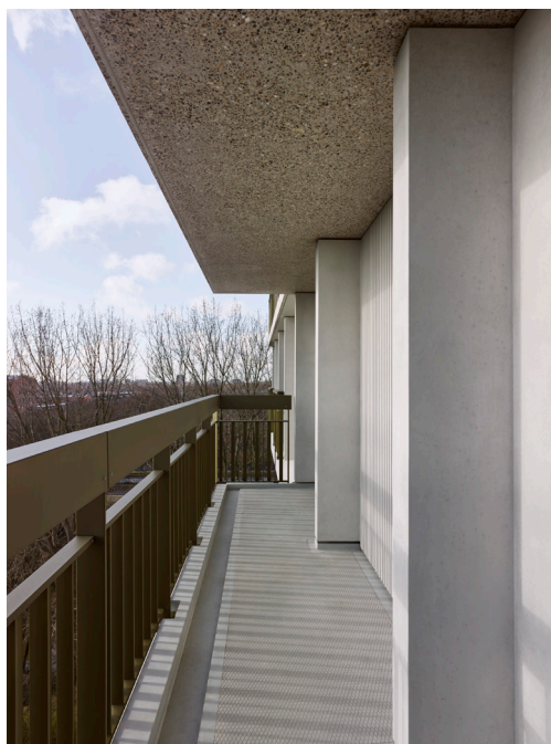
Balkon zuidgevel met gepolijst betonnen plafond
