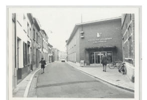
Moensstraat, 1972 Hoofdingang tot de bibliotheek in de Moensstraat, alvorens de uitbreiding en aanleg van het plein met nieuwe toegang in 1996. Opmerkelijk is de beduidende hogere bebouwing zonder garagepoorten aan de overzijde in de Moensstraat.
