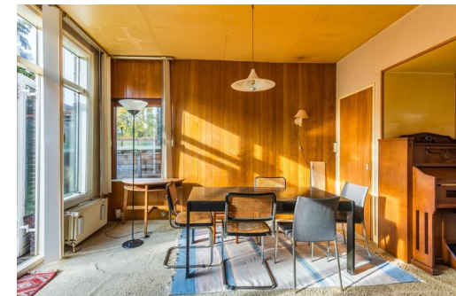
Bestaande situatie eetkamer. Schrootjes en verlaagde plafonds in vijftig tinten geel.
