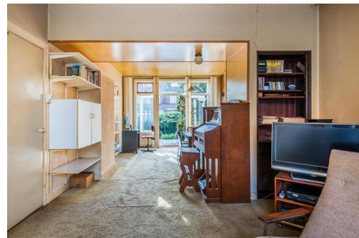
Bestaande situatie woonkamer. De woning was volledig uitgerookt en dichtgetimmerd.
