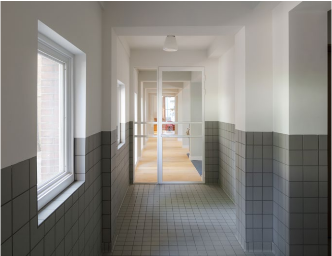
Leistenen vloertegels van de kerkzaal hergebruikt.
