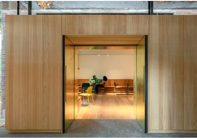
De draagstructuur verborgen in houten kasten.
