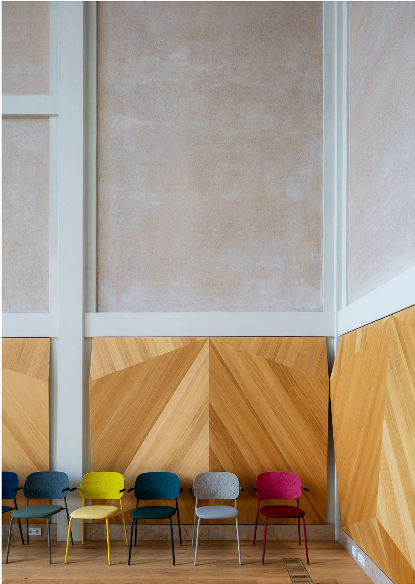
We hebben de akoestiek in de muziekzaal verbeterd met houten 3D-wandpanelen die geluidsgolven verspreiden.
