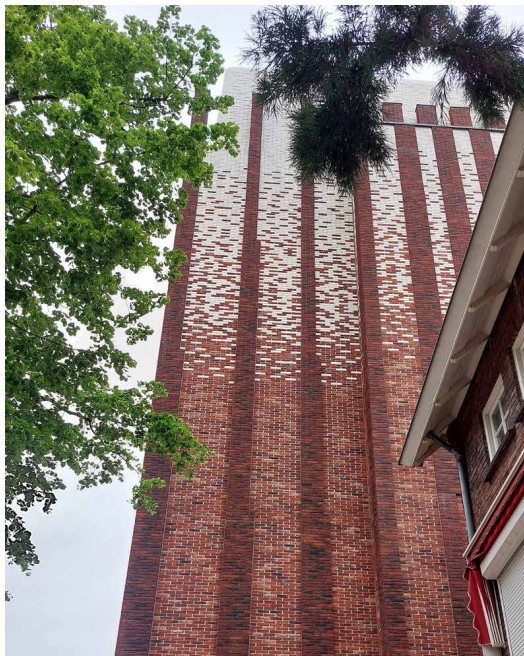
Tessellaties in het metselwerk
