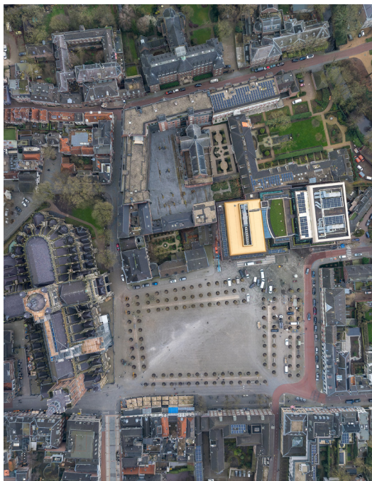
Sedumdak buffert het hemelwater
